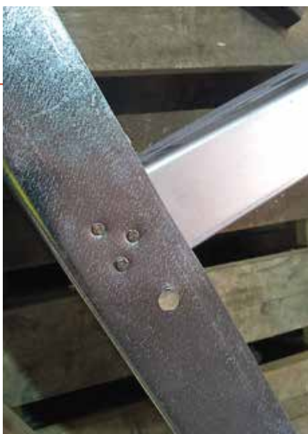
Spikning av skena till regel med lufttryck.
